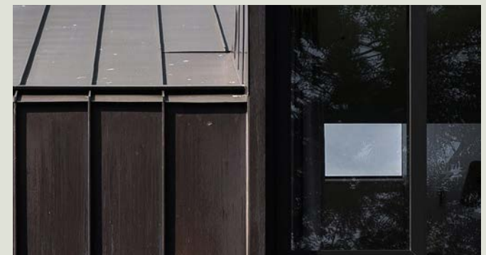
Aluminium gevel en dak en voorbeeld detaillering (Bron: EVA architecten)
